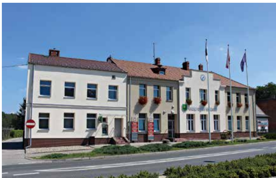
Budynek Urzędu Gminy
