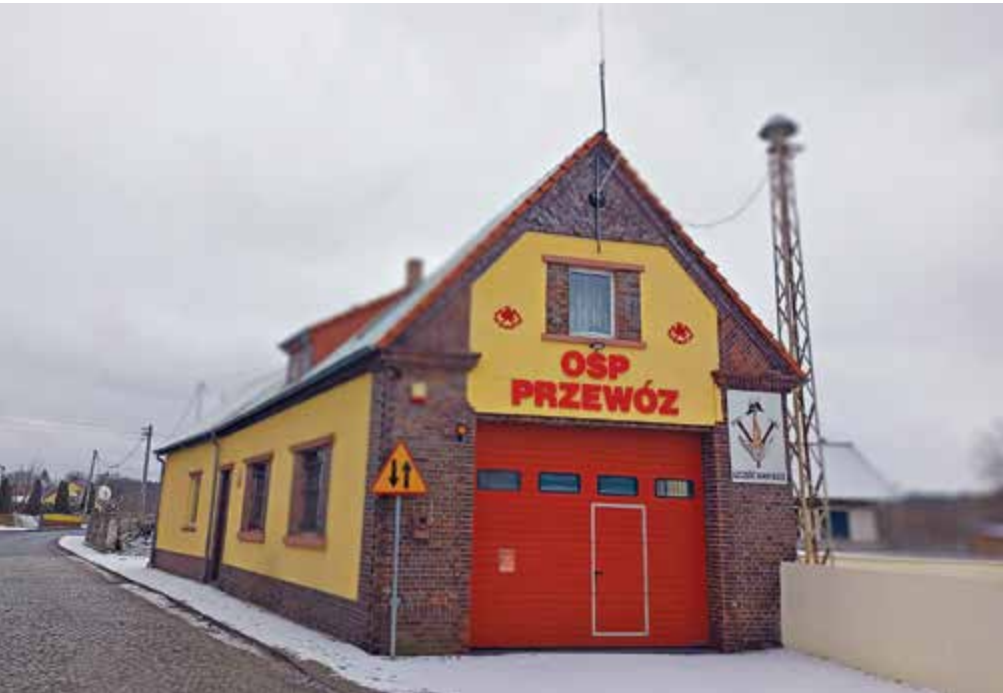
◆ Budynek OSP w Przewozie
